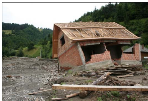
Fig. 161. Valea Covașniței, Poienile de sub Munte (anul 2008)
