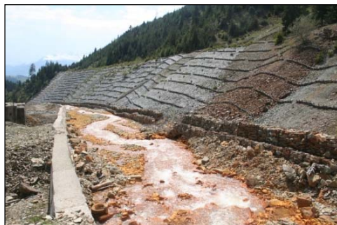
Fig. 168. Încercare de fixare a sterilului pe Valea Secu (Borșa, 2008)
