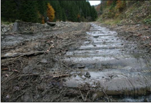
Fig. 110. Drum forestier de vale amenajat cu trunchiuri de copaci dispuși transversal (Valea Berescu, Poienile de sub Munte, 2008)
