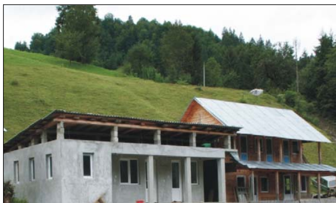
Fig. 123. „Băile noi” Cvașnița (Poienile de sub Munte, 2008)
