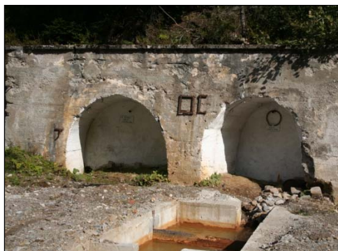
Fig. 98. Guri de mină închise (Mina 9 Mai, 2007)
